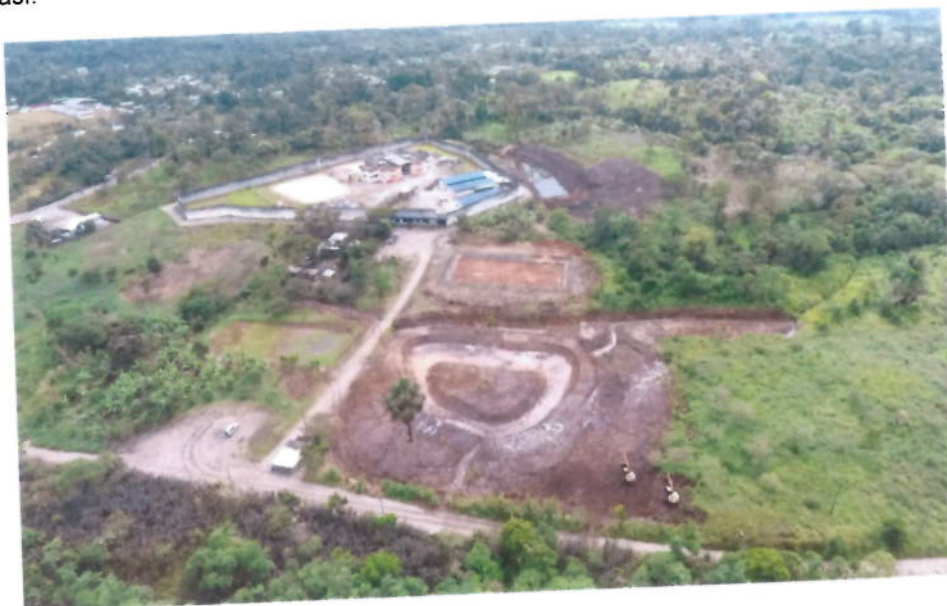
Construcción de piscinas en Centro de Rehabilitación de Archidona
