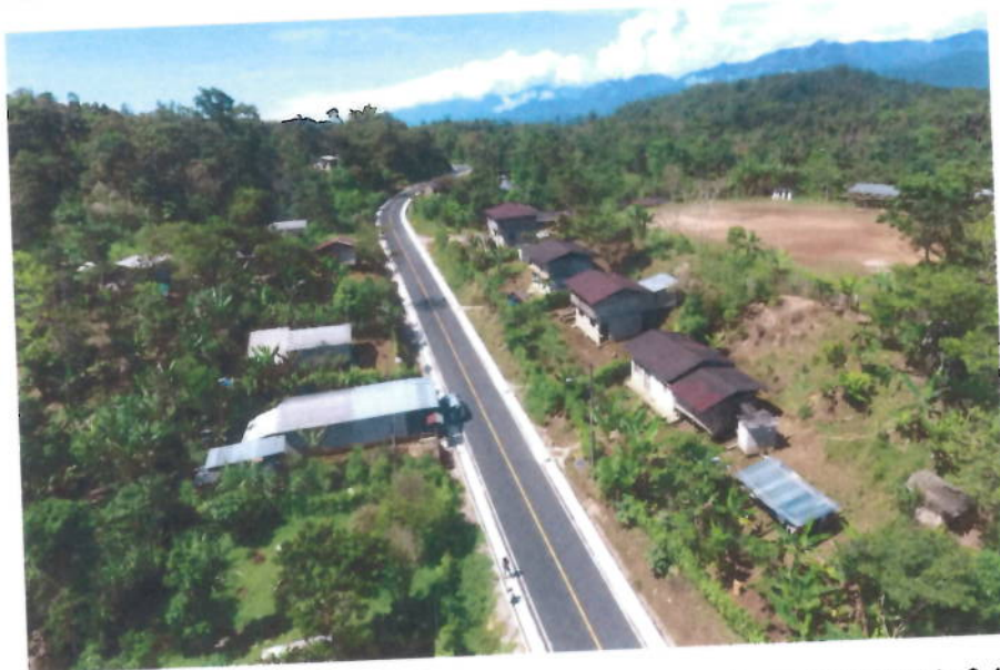
Asfaltado vía Porotoyaku - Lushianta
