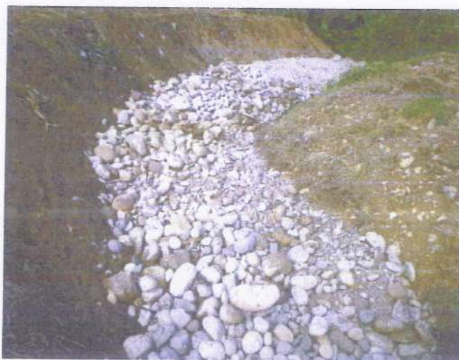
Imagen 04.- Conformación del filtro biológico.
