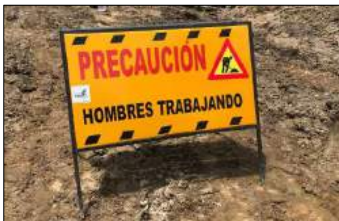
N° 2 Señalización en Obra
