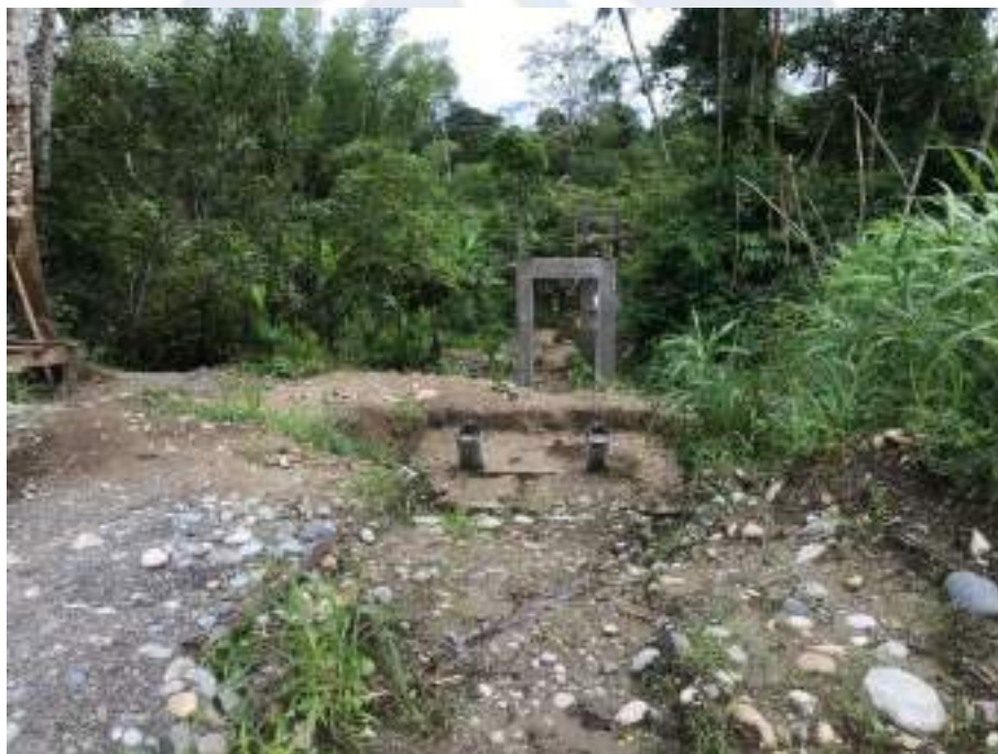
Durante la ejecución
