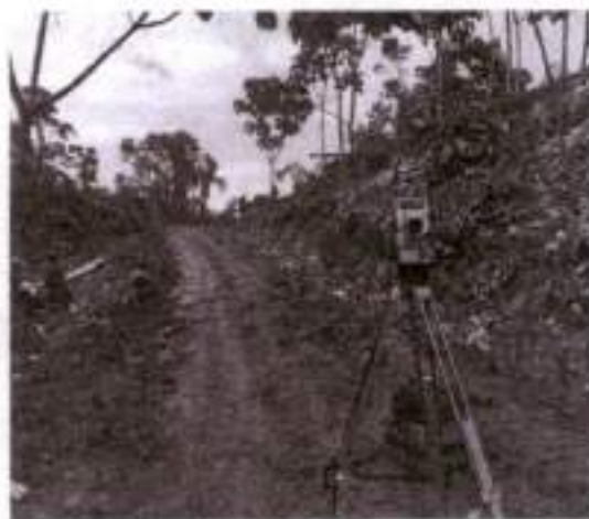
Levantamiento en campo
