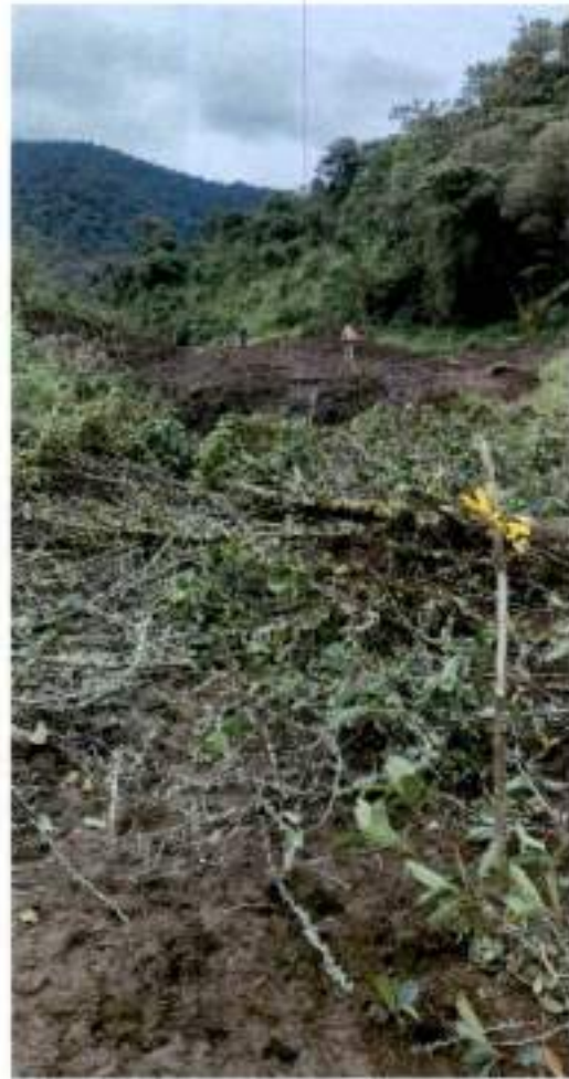
Balizas del replanteo del eje cada 10m
