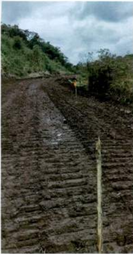
Balizas del replanteo del eje cada 10m
