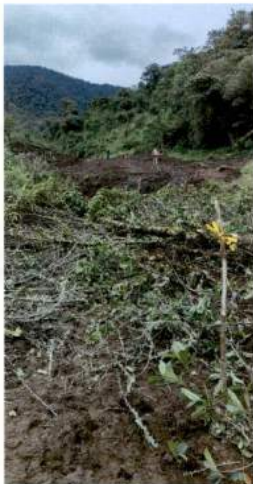
Balizas del replanteo del eje cada 10m
