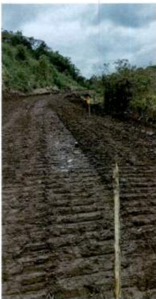
Balizas del replanteo del eje cada 10m
