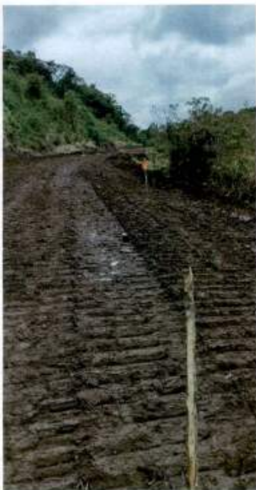
Balizas del replanteo del eje cada 10m
