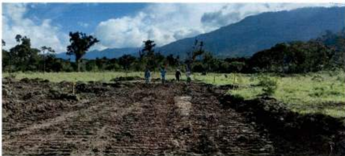
Laterales cada 10m identificando cantidades de cortes y/o rellenos
