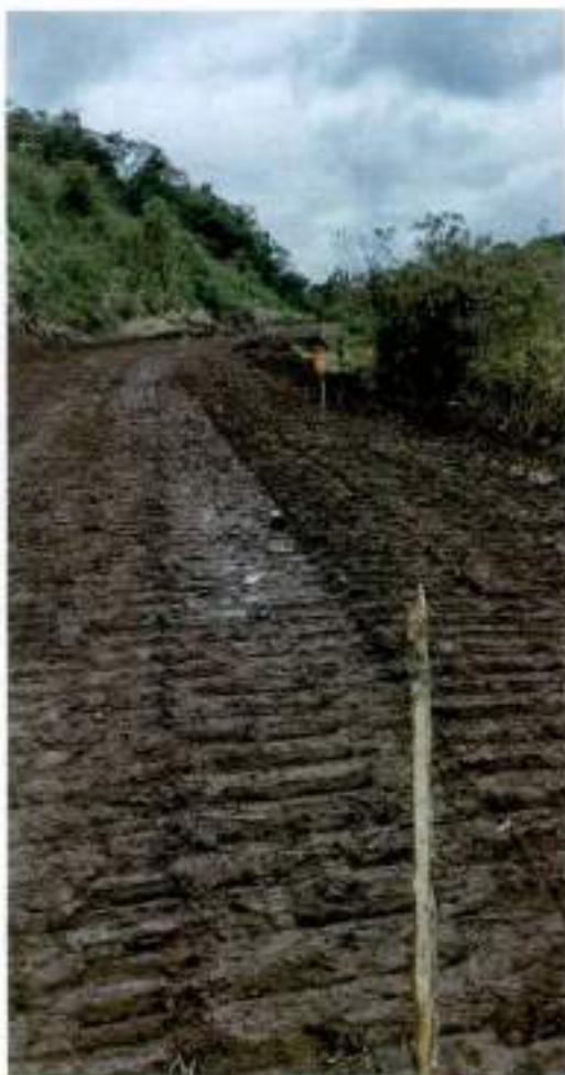
Balizas del replanteo del eje cada 10m
