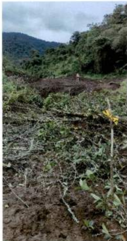
Balizas del replanteo del eje cada 10m
