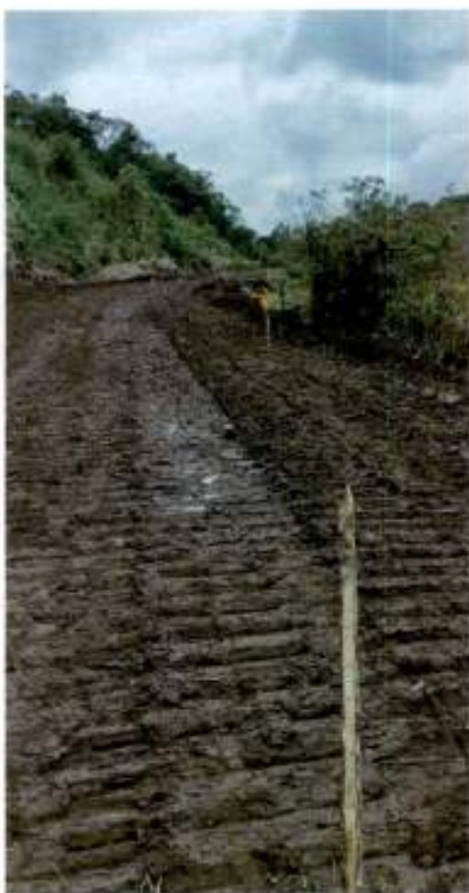
Balizas del replanteo del eje cada 10m
