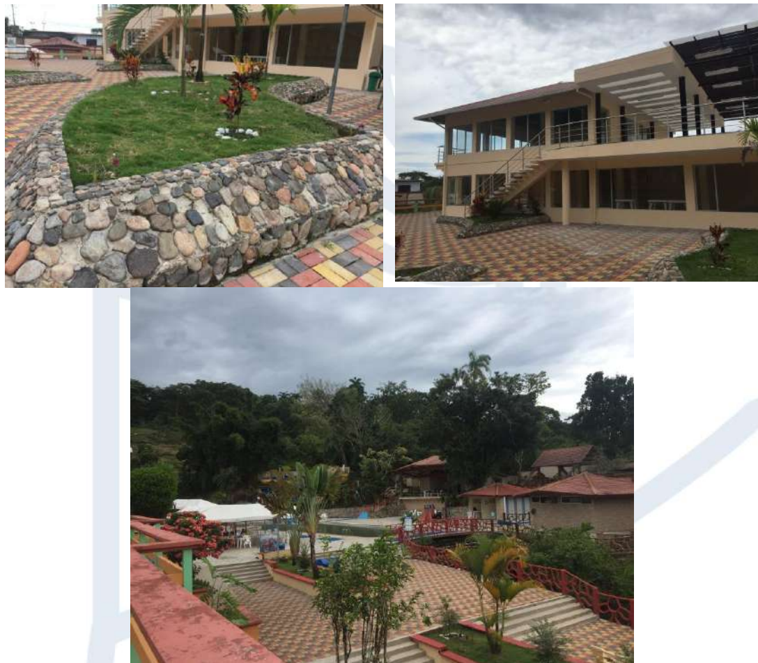
Fotografía No. 12.- Finalización de la obra
