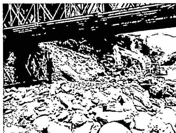
11/08/2021: Construcción bajo el nivel de socavamiento (lecho del río) de la base para el muro L= 50 m , (supervisión de trabajos, control asistencia del personal)
