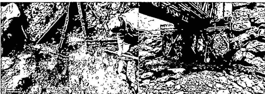
18/08/2021: Construcción de muro para protección de estribo, conformación de taludes con material de relleno transportado desde mina Santa Rosa y San Juan Chico, (supervisión de trabajos, control asistencia del personal)
