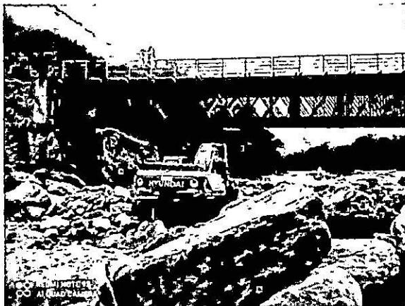
08/08/2021: Desazolve de río para desvío del mismo y extracción de piedras para el muro, (supervisión de trabajos, control asistencia del personal)
