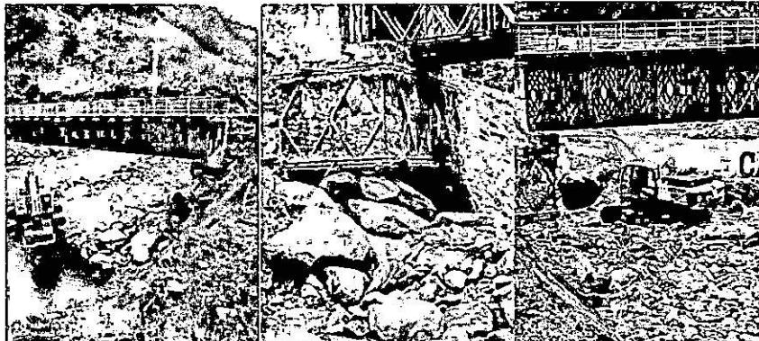
16/08/2021: Construcción muro de piedra tipo escollera L= 50 m hasta nivel de base del estribo, conformación de taludes (supervisión de trabajos, control asistencia del personal)
