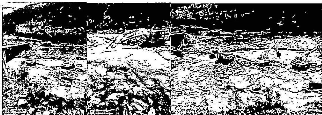
03/08/2021: Desazolve de río para desvío del mismo y extracción de piedras para el muro, trasporte de material de relleno desde la mina de Santa Rosa Hasta el sitio del trabajo
