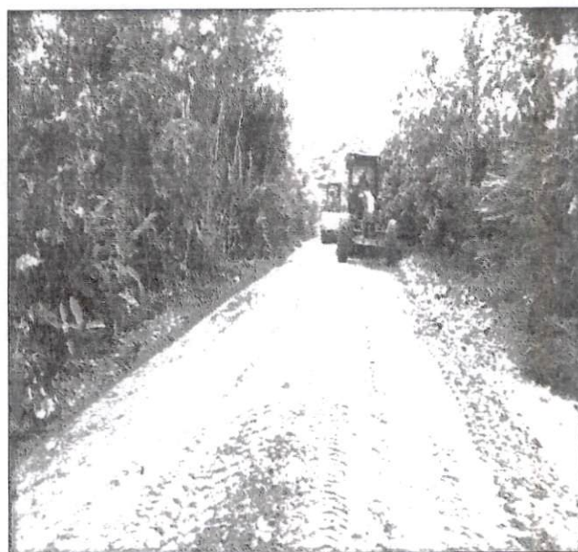
Fotografía 3.- Reconformado y compactado vial
