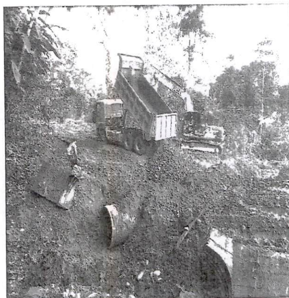
Fotografía 7.- Relleno de alcantarilla
