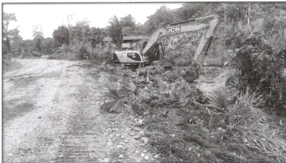
Fotografía 2.- Limpieza de alcantarilla y encausamiento de cunetas
