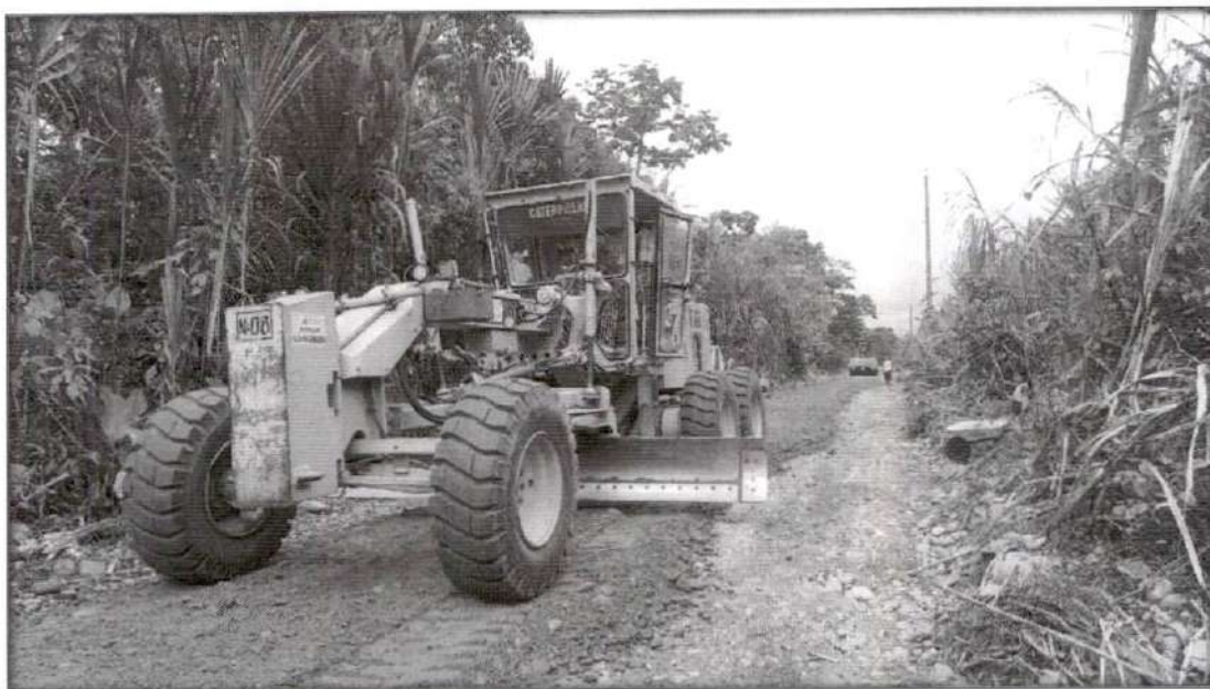
Fotografía 1.-Limpieza, reelatrado, reconformado y compactado vial
