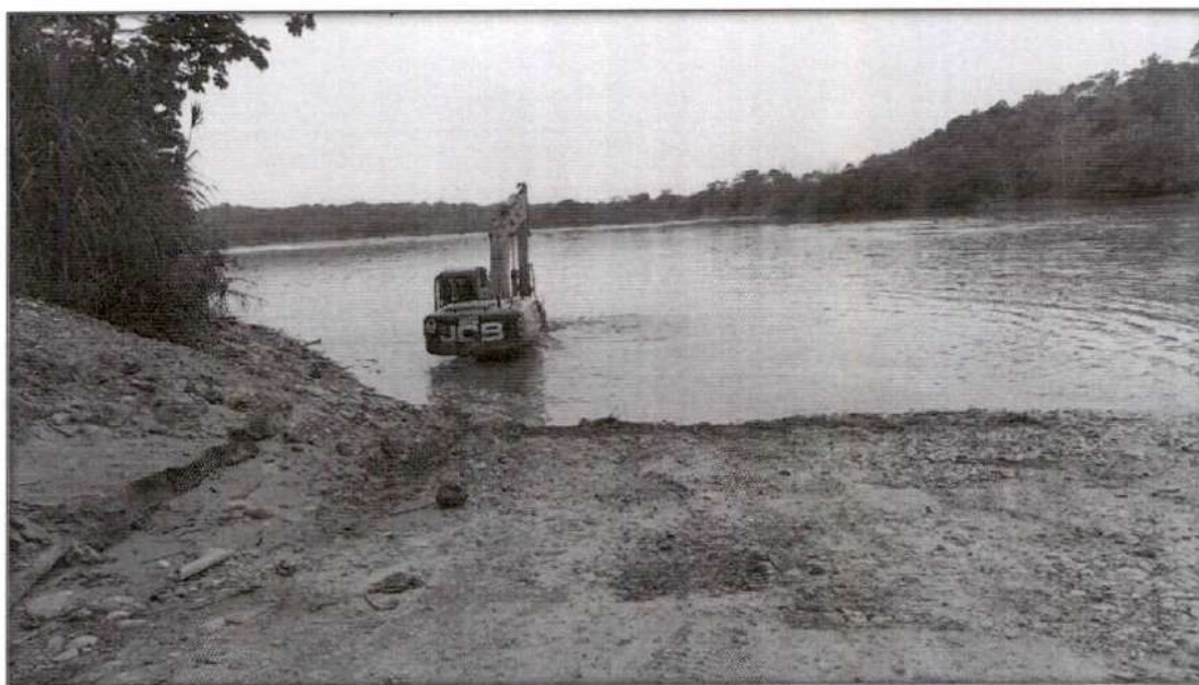
Fotografía 6.- Gragado del rio Napo en el Puerto de la Gabarra de Agua Santa
