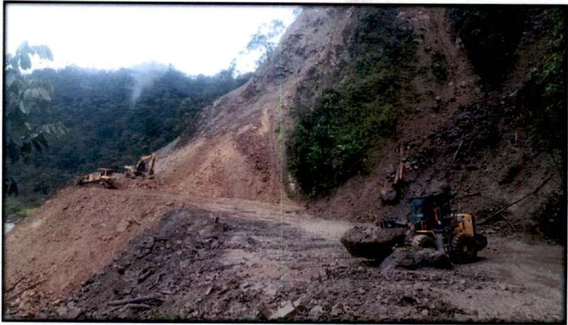
Fotografía 1.- Limpieza de la vía y desalojo de escombros.
