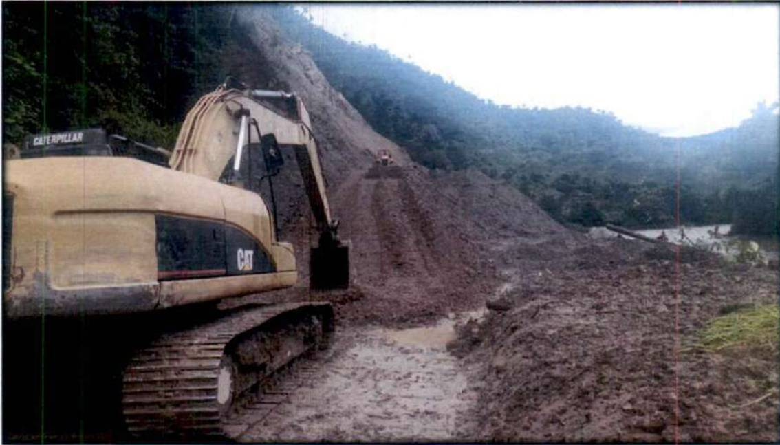
Fotografía 3.- Reconformación de la mesa vial.
