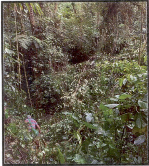
Limpieza y desbroce eje
